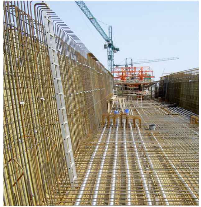
Armierung aus Stahl vor dem Betonguss
