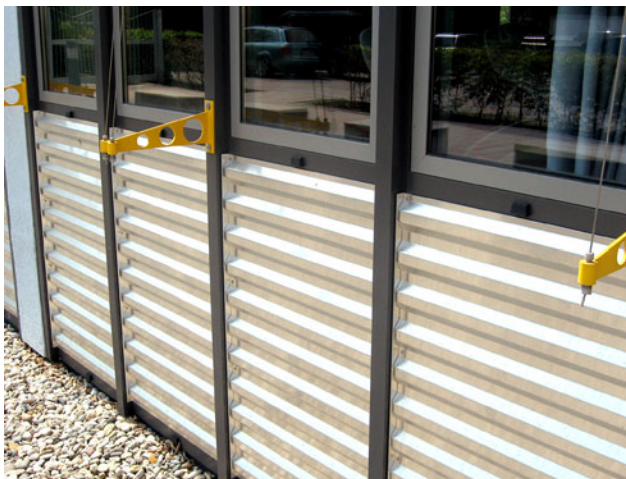
Außenverkleidung einer Wand mit Aluminiumblech
