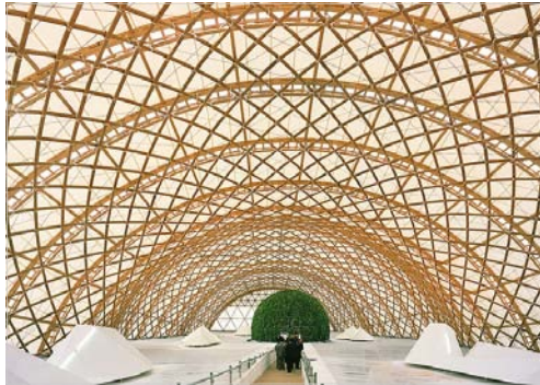
„Paper Pavillon“ der Expo 2000 in Hannover mit einem tragenden Gitter aus 12,5 cm dicken Papierrollen mit 40 m Spannweite.
